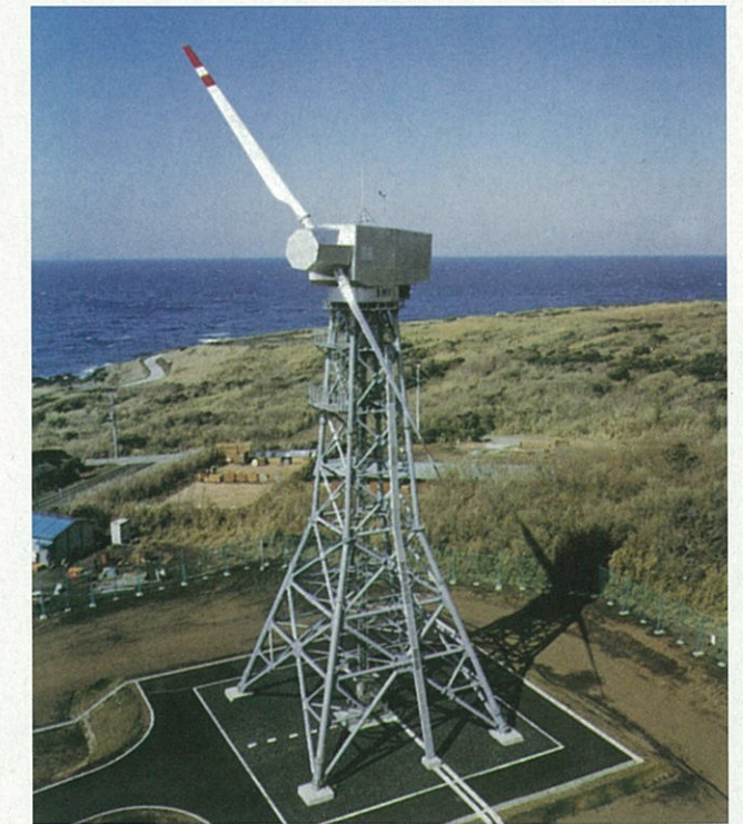
100kW級風力発電実験機(東京都三宅島)
