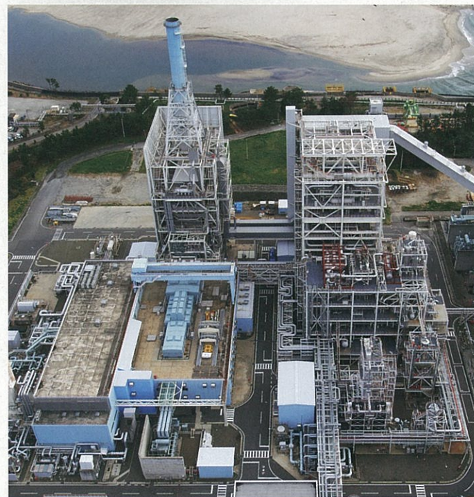
常磐共同火力勿来発電所(福島県いわき市)
