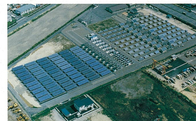
六甲新エネルギー実験センター(兵庫県神戸市)
